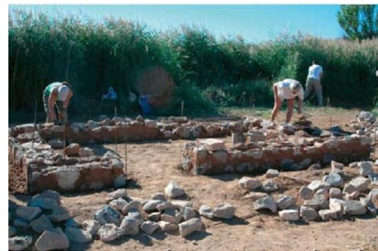
Fig. 5- Délimitation du plan de la maison (a) et élévation du socle en pierres (b).
