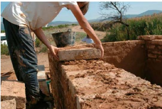
Fig. 6- Élévation des murs en carreau et boutisses.
