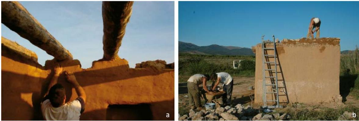
Fig. 7- Emplacement des poutres pour la toiture et leur ancrage au mur.
