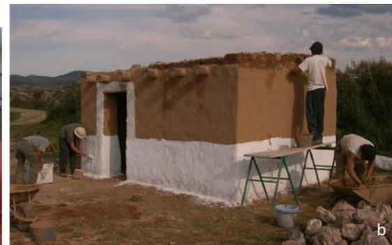
Fig. 9- Finitions des murs en appliquant : (a) une couche d'argile et (b) une couche d'enduit de chaux pour la partie inférieure.
